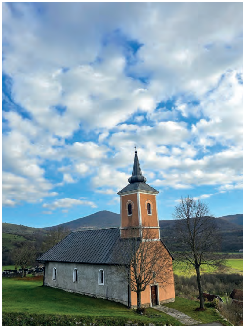
Slika 28: Crkva sv. Mihovila, sjeverno pročelje
